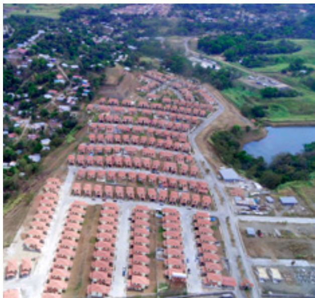
› Asentamientos humanos informales de la ciudad de Panamá que contribuyó al proceso de expansión
