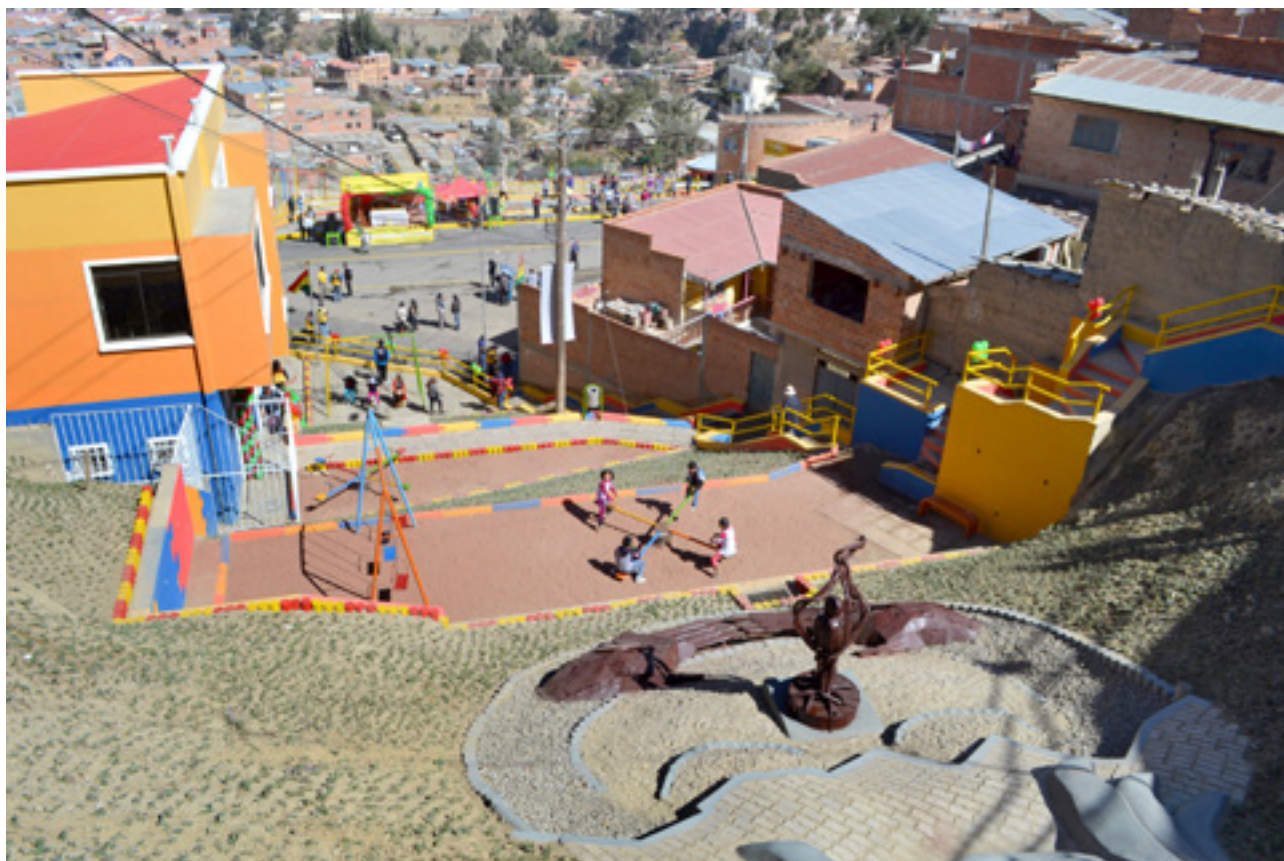
› Barrio San Antonio Bajo después de intervención
