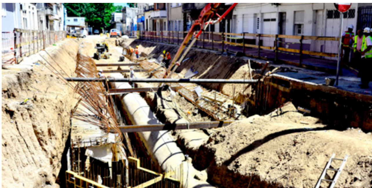
› Extensión redes de saneamiento. Autor: ArtigasPessioVignolo
