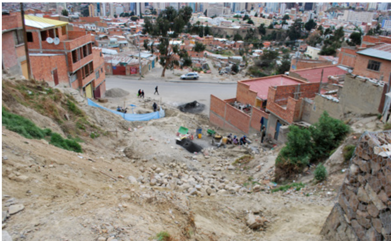
› Barrio San Antonio Bajo. Antes de intervención
